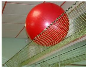
Рекомендована для небольших фитнес-студий, ограниченных в свободном пространстве. Располагается между двух стен. Представляет из себя 2 натянутых троса в пластиковой безопасной оболочке. Использование сетки делает конструкцию практически незаметной и не утяжеляющей внешний вид зала. Установка возможна только между капитальными стенами. Изготавливается исходя из размеров зала и индивидуальных пожеланий заказчика.
